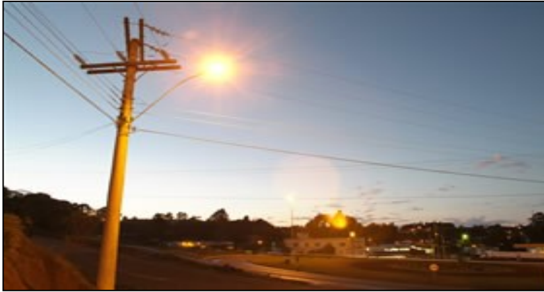
Figura 2.20 - Poste, rede de energia elétrica via aérea
