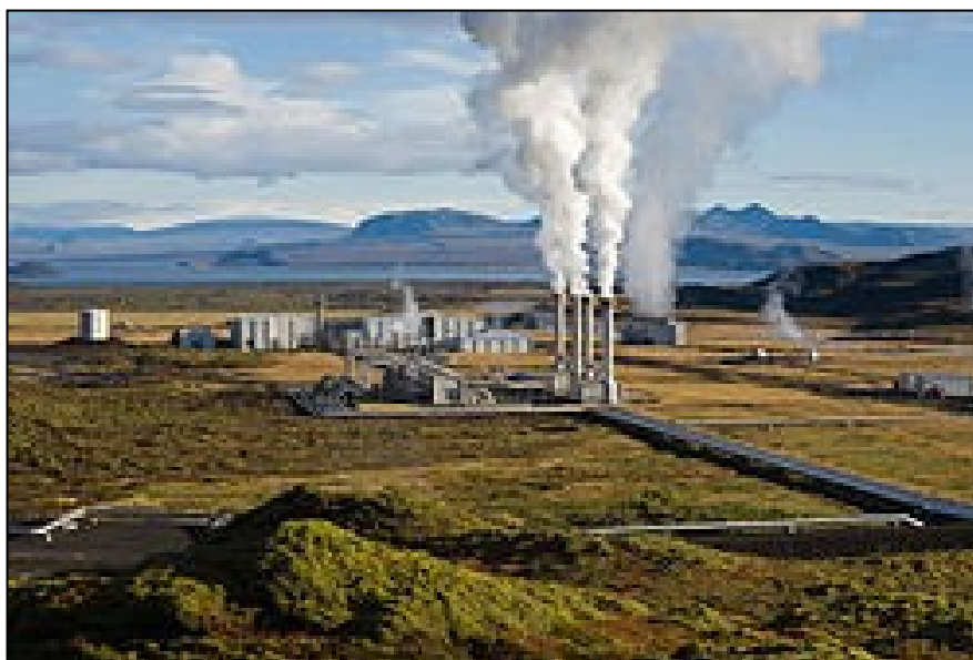
Figura 2.6 - Usina geotérmica de Nesjavellir, próxima a Pingvellir, Islândia
