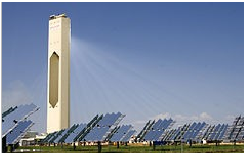
Figura 2.3 - Usina Solar PS10, Espanha
