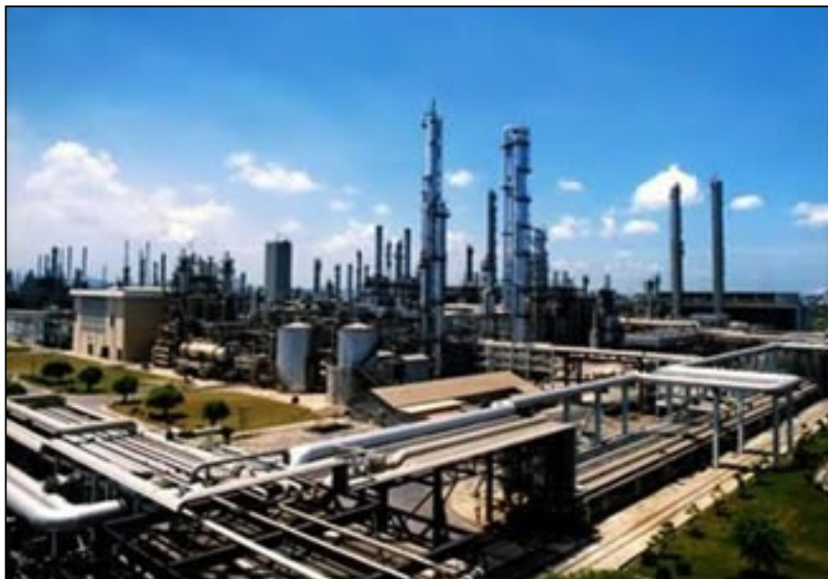
Figura 2.10 - Usina de gás Natural
